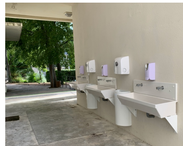
3 auges doubles avec distributeurs savon, essuie-mains et poubelles à proximité du self
